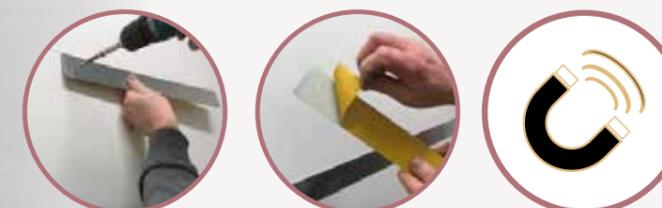
Les panneaux muraux ultralégers DIVI smart® sont équipés d'aimants sur le côté face. Installation Facile: coller ou visser les rails métalliques appropriés au mur et poser les panneaux.
