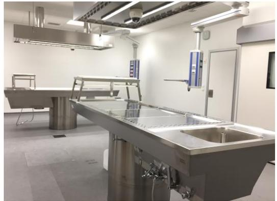
Hotte d'air frais avec luminaires encastrés à DEL et caméra vidéo (solution personnalisée)
