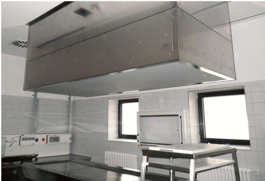
Hotte d'air frais à flux laminaire avec placage supplémentaire
