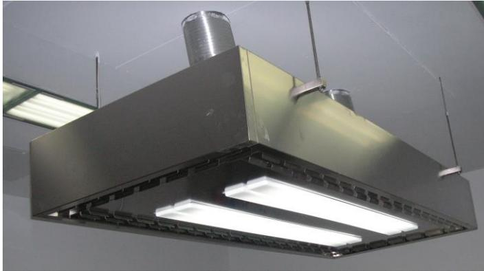
Hotte d'air frais avec luminaires encastrés à DEL
